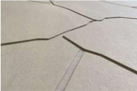
Las placas de fibrocemento Eterboard Piedra Natural, elaboradas con cemento, sílice, fibras de celulosa y aditivos, son curadas en autoclave y ofrecen un acabado que imita piedras naturales. Cumplen con la norma NTC 4373 para placas planas de fibrocemento de calidad.
