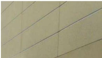
Las placas Eterboard Tablilla Lisa simulan un acabado tipo ladrillo. Están fabricadas con cemento, sílice, fibras de celulosa y aditivos, fraguadas en autoclave, y cumplen con la norma NTC 4373 para placas planas de fibrocemento de calidad.
